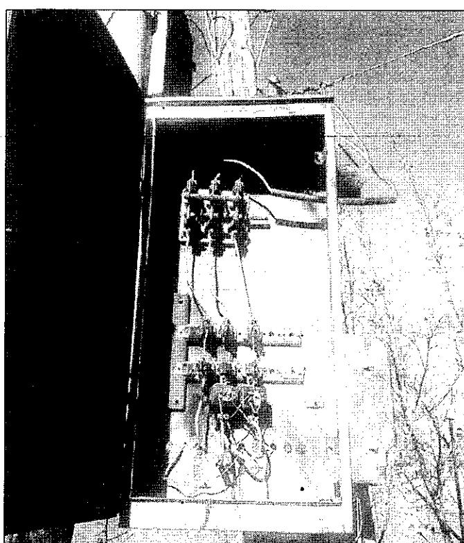
подачи напряжения 0,4 кВ на трансформатор МТП-1-2/63 и обратную трансформацию напряжения уровня 10 кВ на шпильки вводов трансформатора.
