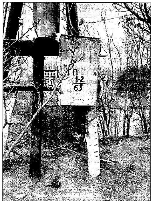
По результатам осмотра ВЛ 0,4 кВ Ф-1 МТП-1-2/63 была выявлена однофазная перемычка между проводом ВЛ 0,4 кВ Ф-1 КТП-1-1/400 и проводом ВЛ 0,4 кВ Ф-1 МТП-1-2 ВЛ-10 кВ Ф-1 ПС 35 кВ Карата, что послужило способом
