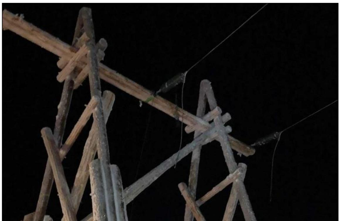
В 14:40 диспетчером производственно-диспетчерской службы УВБС АО «НТЭК» было дано разрешение допускающему - старшему мастеру участка оперативного обслуживания Службы линий РЭС-1 УВБС АО «НТЭК» на допуск бригады СМУ «СЭМ» ООО «ПСМК» к производству работ на ВЛ-110 кВ ЛЭП-182 от Р-25 по демонтажу проводов и монтажу проводов на новую опору по наряду-допуску для работы в электроустановках № 941.
