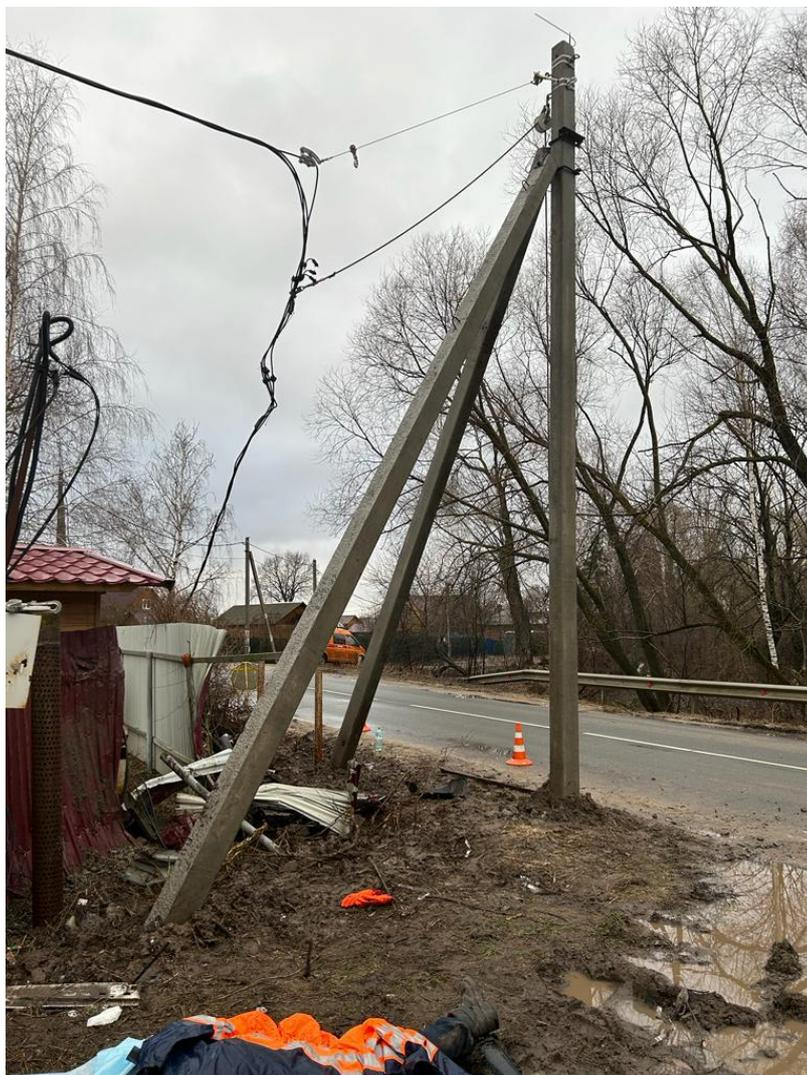
На следующий день для проведения аварийно-восстановительных работ по ремонту трехстоечной опоры № 6 ВЛ- 0,4кВ фид. к фид. 2 от ТП-280 (трансформаторная подстанция) с применением подъемника автомобильного
